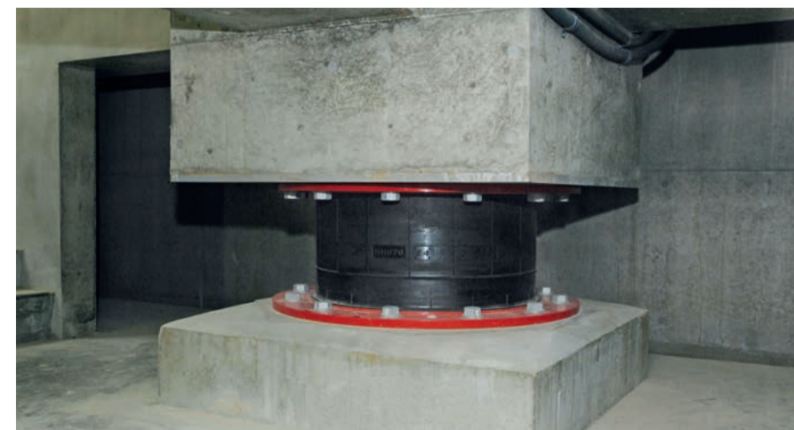
耐震構造: 建物基礎部に減衰構造
